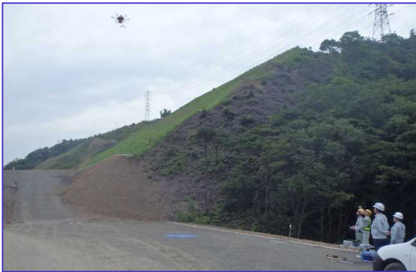
UAV(ドローン)による施工前の測量 (6月9日撮影)
