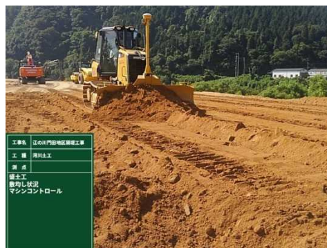
MCブルドーザ 施工状況
