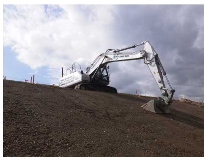
3DMGバックホーによる法面整形
