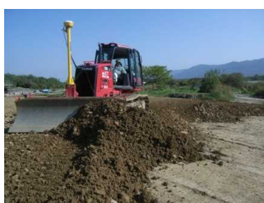
MCブルドーザーによる 盛土作業
