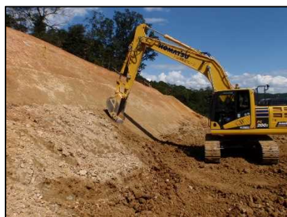
ICT(MG,MC)バックウによる切土法面整形状況
