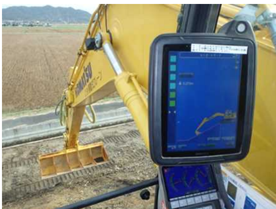
3DMC機による法面整形
