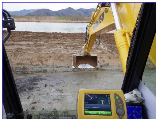
ICTバックホウによる掘削および法面整形
