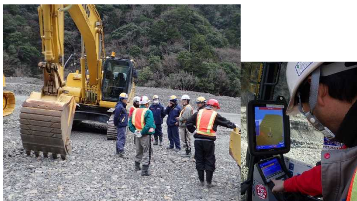
MCバックホウによる講習会実施 (モニター確認も併用)
