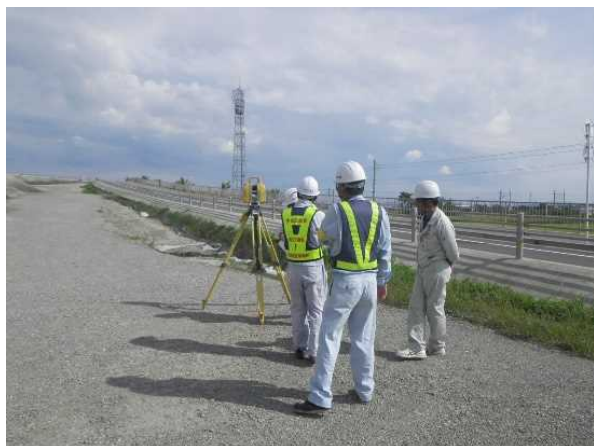
レーザースキャナーによる施工前の測量
