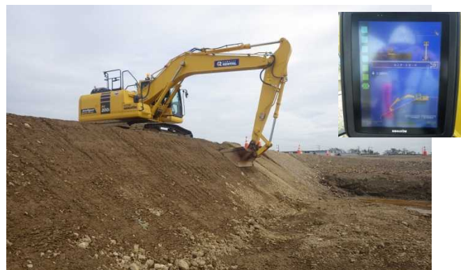
ICTバックホウによる法面整形
