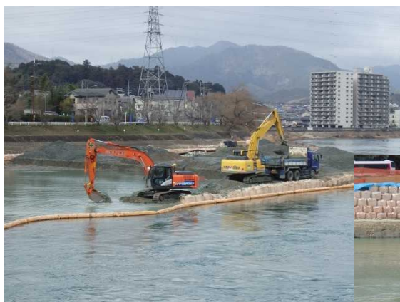
MGバックホウによる水中掘削
