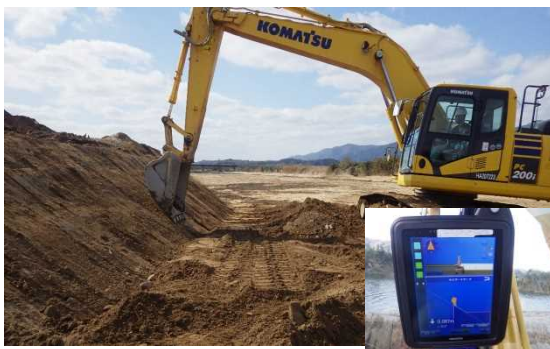
MCバックホウによる法面整形 (モニター確認も併用)
