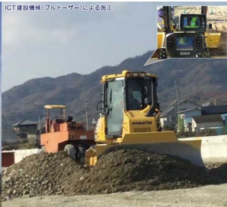
施工者4社合同によるMC ブルドーザーによる 路床盛土工の技術者見学 会の実施
