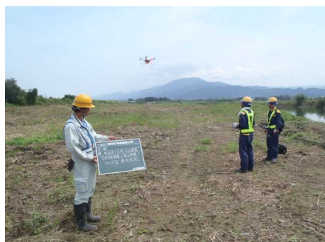
UAVによる起工測量
