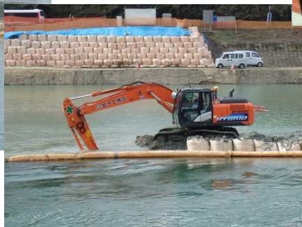
MGバックホウによる水中掘削
