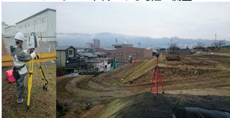
レーザースキャナーによる起工測量
