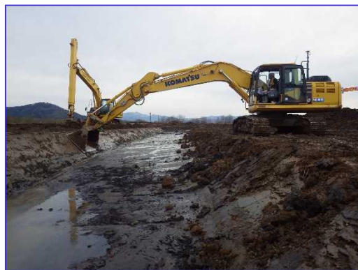
ICTバックホウによる掘削および法面整形
