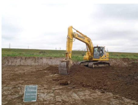
ICTバックホウによる掘削
