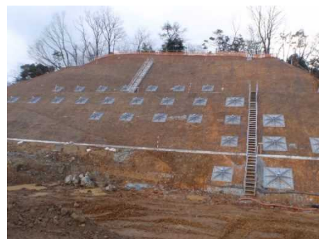
法面に構造物がある箇所は3次元の出来形管理が困難
