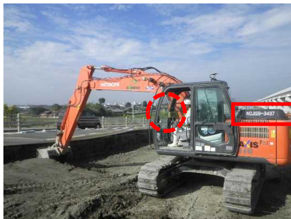
マシンガイダンス(バックホウ)による掘削
