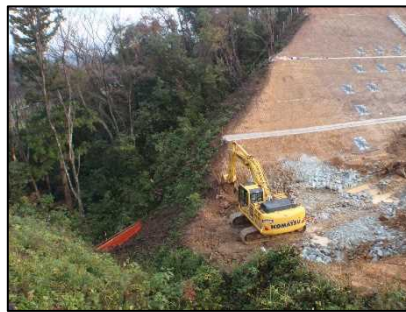
ICT(MG,MC)バックウによる切土法面整形状況
